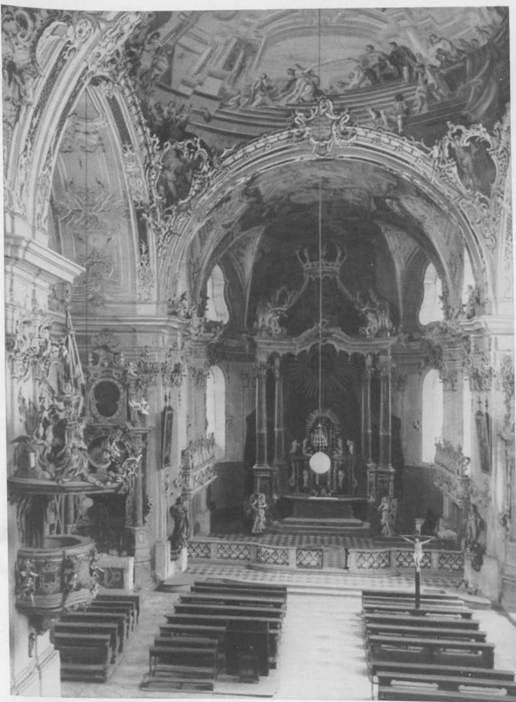
Abb. 15 Barockbau, Inneres rokokoiert, Pfarrkirche Wilten, Innsbruck
